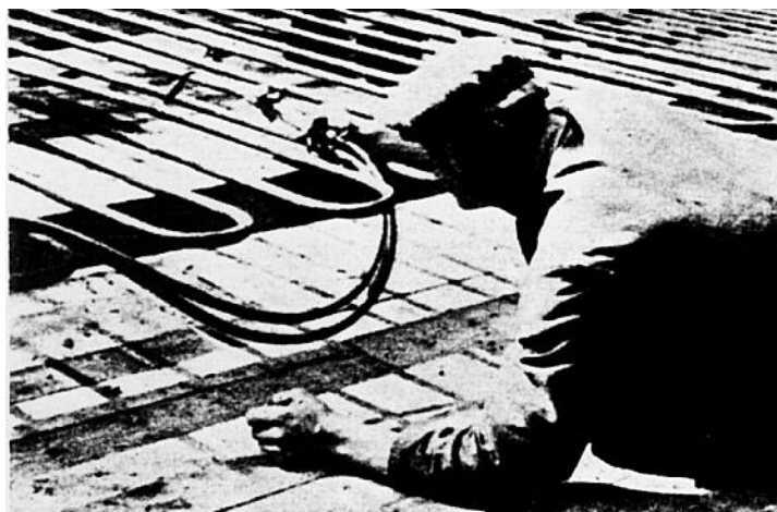
Стальные сварные трубы перед бетонированием (1937)
