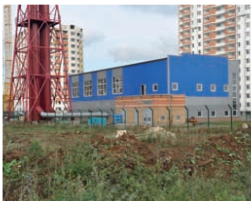
Котельная мощностью 58 МВт, мкр. Щитниково, Московская область
