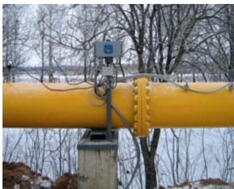
Измерительный узел на базе ультразвукового расходомера «Гиперфлоу-УС»
