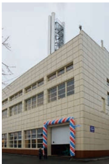
Квартальная котельная 58 МВт на ул. Красного Курсанта, д. 20
