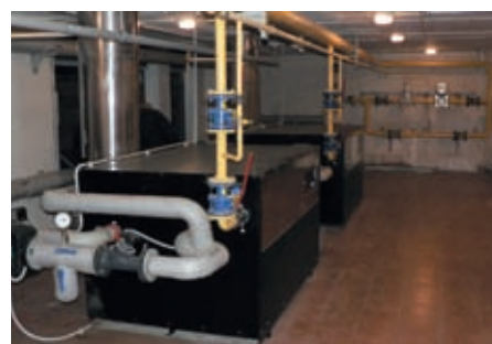
Торгово-сервисный центр (г. Энгельс), поставка водогрейных котлов для котельной
