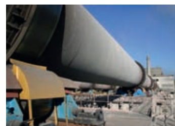
Монтаж трубопроводов и металлоконструкций, работы по изоляции на щуровском цементном заводе (заказчик – ЗАО «Щуровский цемент» (Holcim))
