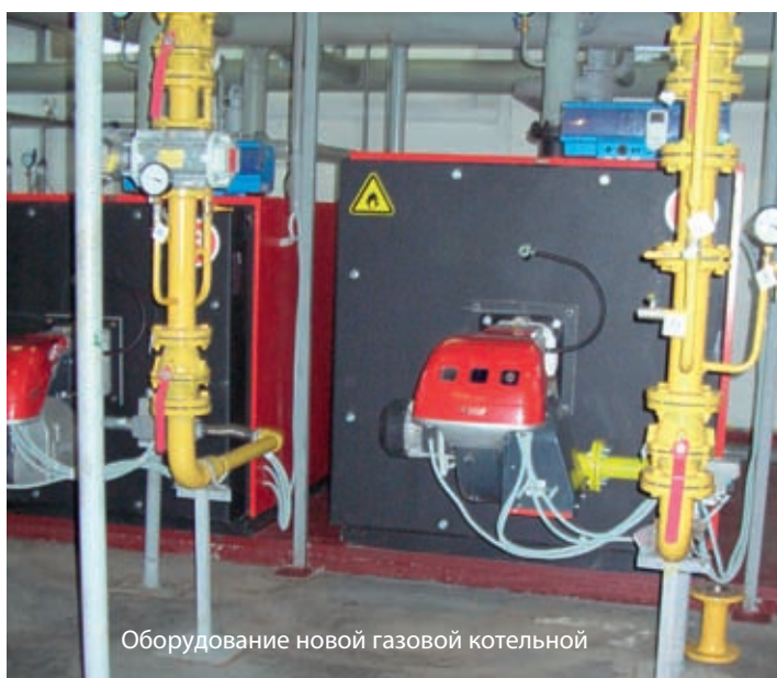
Котельная после реконструкции
