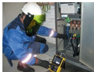
Замеры параметров работы электроустановки
