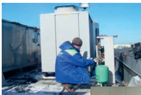
Монтаж климатического оборудования
