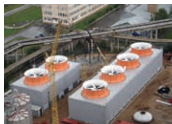
Монтаж трубопроводов и металлоконструкций, работы по изоляции на «Монди Сыктывкарский ЛПК» (заказчик – группа Mondi)
