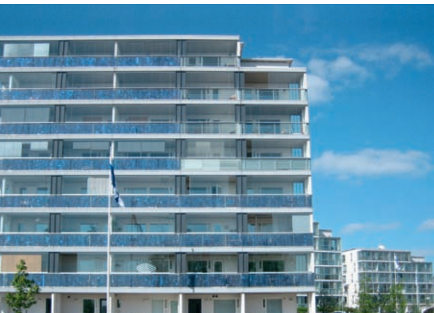
Солнечные панели, встроенные в лоджии квартир (пос. Виикки, Финляндия)
