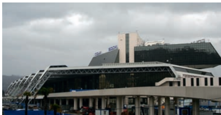
Здание Международного аэропорта г. Сочи
