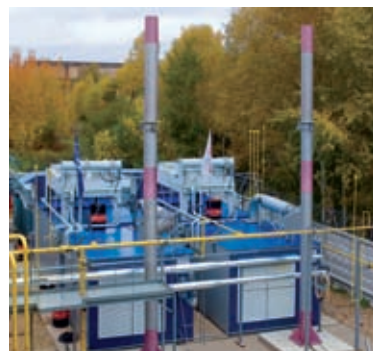
Строительство мини-ТЭС для завода «Тверьстеклопластик»
