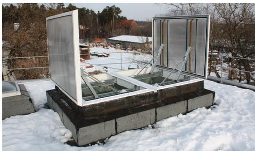
Дымовые люки (фонари) КЛАПАР® выпускаются со светопрозрачной крышкой, выполняемой из монолитного поликарбоната, акрила, сотового поликарбоната или их комбинации (всего 7 типов конструкций крышки, отличающихся значением приведенного сопротивления теплопередаче), или с теплоизолированной непрозрачной крышкой. Применение монолитного поликарбоната в крышках купольного и пирамидального типов обеспечивает их высокую механическую прочность.
