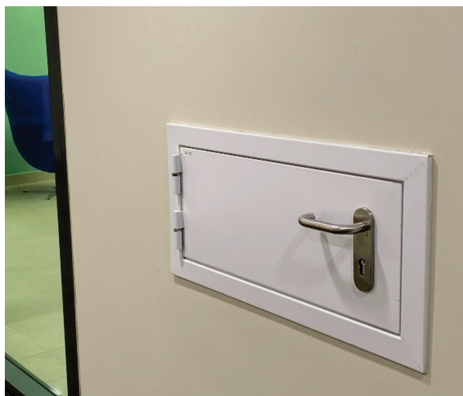
■ Рис. 14. Люк доступа в огнестойком исполнении
