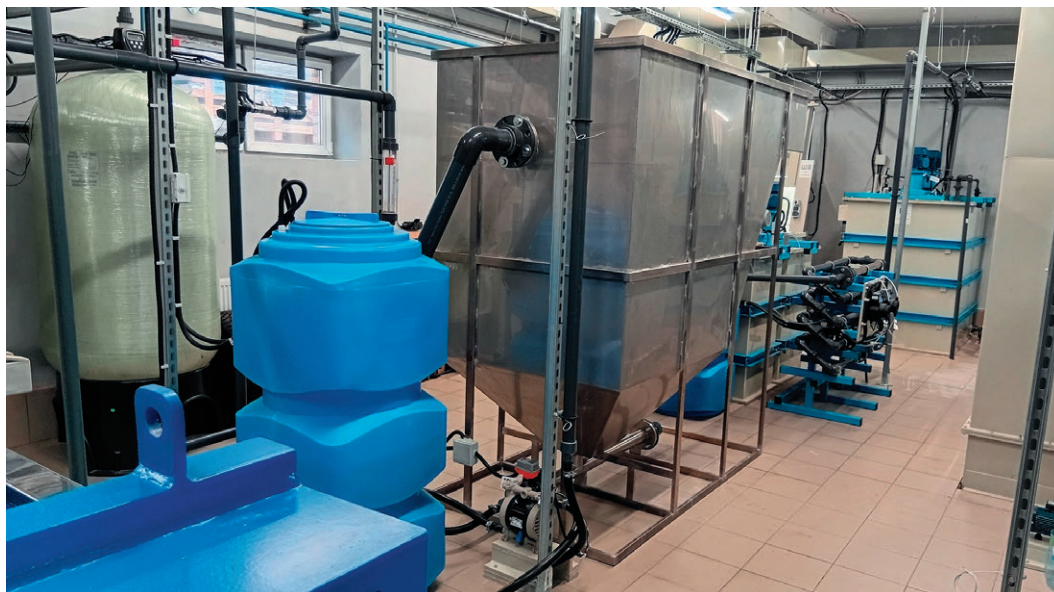
Рис. 2. Общий вид очистных сооружений гальванического производства АО «МЭЛ»
