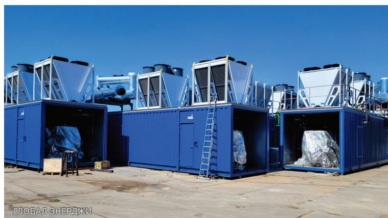
■ Рис. 3. Размещение V-образных изделий серии BVDA на крыше контейнера
