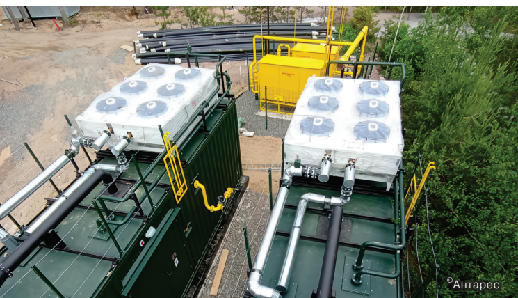
■ Рис. 2. Размещение горизонтальных изделий серии NORMA на крыше контейнера
