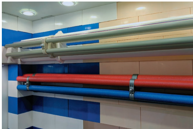
Крепеж труб с двумя типами изоляции: простота монтажа налицо
