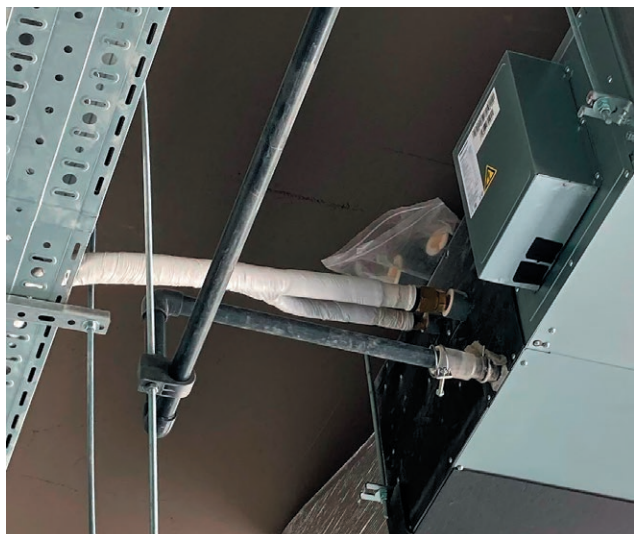
Пластиковый трубный хомут фиксирует трубу, питающую кондиционер хладагентом
