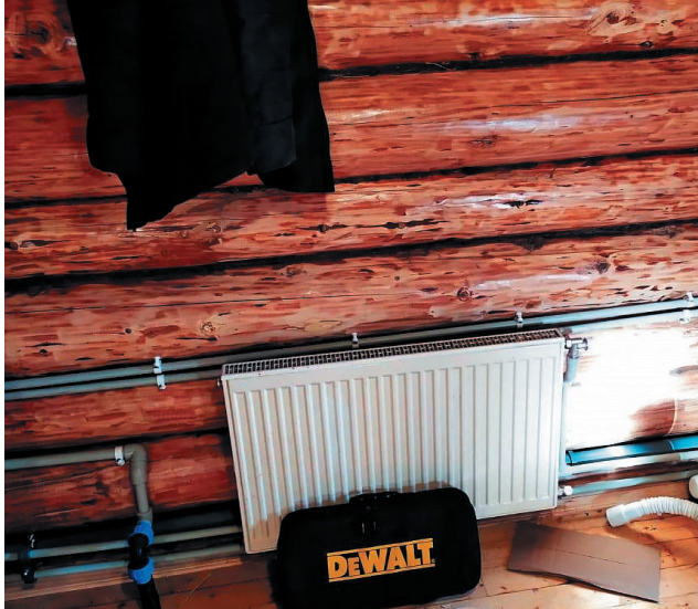
Крепление труб отопления в деревянном доме
