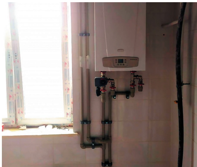
Разводка труб горячего и холодного водоснабжения у бойлера
