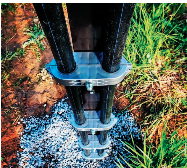
Крепление подвода кабелей к раздаточной коробке
