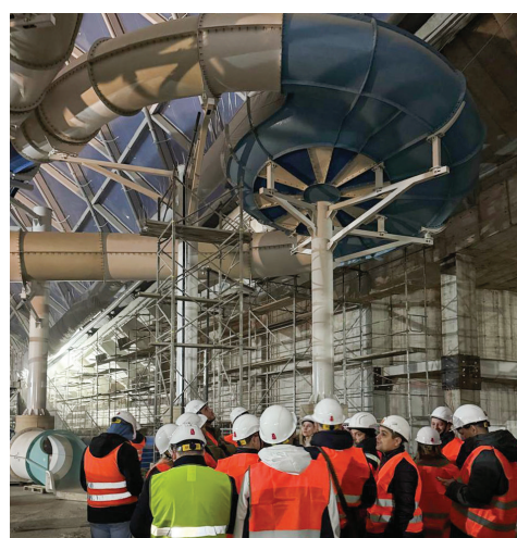
■ Строящийся аквапарк в «Завидово Парке»
