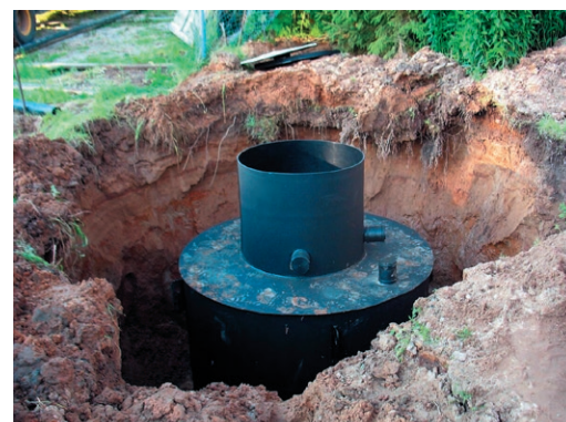
Полиэтиленовый септик в вертикальном исполнении с грунтозацепом и пятью вариантами расположения входного и выпускного патрубков
