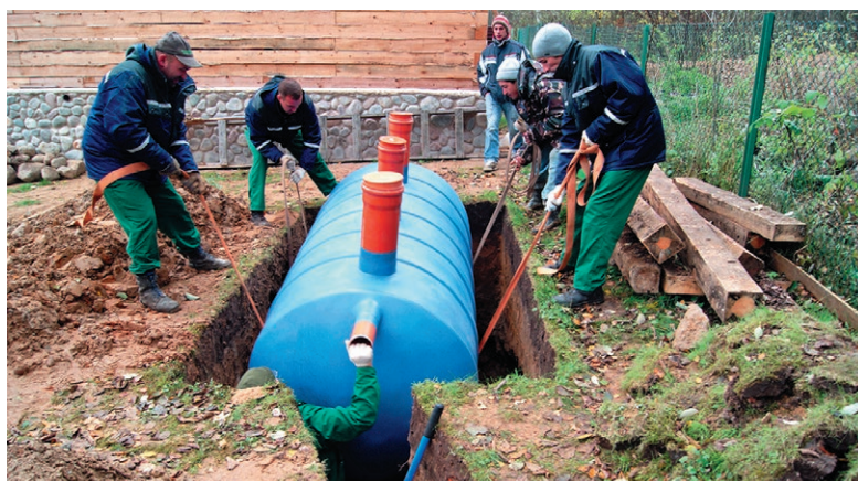
Установка стеклопластикового септика в котлован
