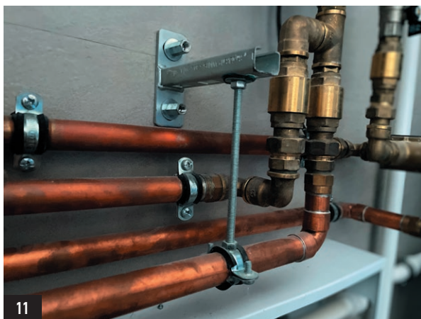
7 – монтаж теплого пола с использованием скоб; 8, 9 – крепеж для труб при прокладке в специальных плинтусах; 10 – стальные хомуты для труб из нержавеющей стали; 11 – монтажные консоли; 12 – стальные хомуты для систем внутренней канализации
