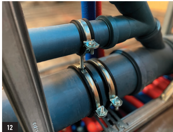
7 – монтаж теплого пола с использованием скоб; 8, 9 – крепеж для труб при прокладке в специальных плинтусах; 10 – стальные хомуты для труб из нержавеющей стали; 11 – монтажные консоли; 12 – стальные хомуты для систем внутренней канализации
