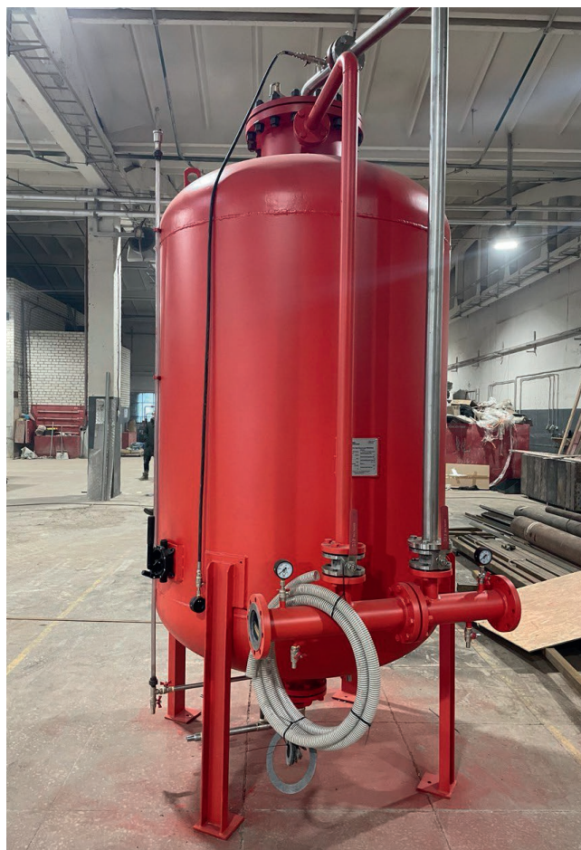
Рис. 4. Бак-дозатор (слева) и принцип его действия (справа): 1, 2 – шаровый кран дренажа дозатора; 3 – диффузор; 4 – дозирующая шайба; 5 – шаровый кран для слива пенообразователя; 6 – шаровый кран для слива воды; 7 – вода; 8 – пенообразователь; 9 – шаровый кран для дозирования бака пенообразователем; 10 – внутренняя эластичная емкость; 11 – шаровый кран для удаления воздуха; 12 – предохранительный клапан; М – манометр
