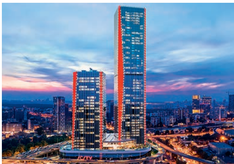
■ Решение сложных инженерных задач на высотных объектах
