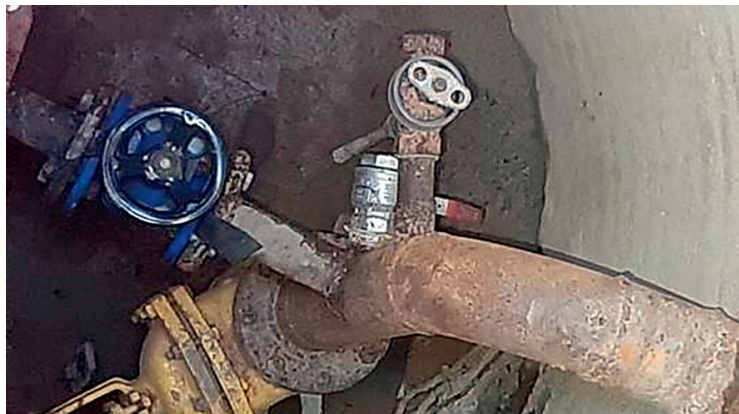
Рис. 5. Работоспособное состояние колодца ВС
