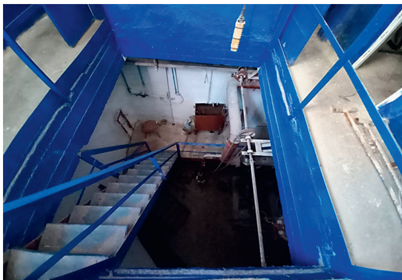
Рис. 4. Ограждающие конструкции КНС сельского поселения. Пример поддержания высокого уровня технического состояния конструкций
