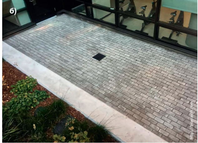
Рис. 2. Материалы, выделяющиеся экологическими показателями своего жизненного цикла: а) теплоизоляция для горизонтальных поверхностей на основе водорослей Posidonia oceanica , коммерческое наименование продукта NeptuTherm®; б) плитка для мощения на основе грунта, проект Exterior courtyard, 2015
