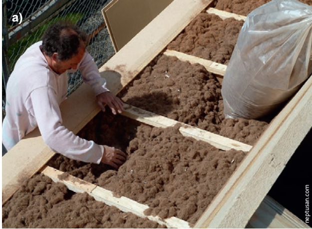
Рис. 2. Материалы, выделяющиеся экологическими показателями своего жизненного цикла: а) теплоизоляция для горизонтальных поверхностей на основе водорослей Posidonia oceanica , коммерческое наименование продукта NeptuTherm®; б) плитка для мощения на основе грунта, проект Exterior courtyard, 2015
