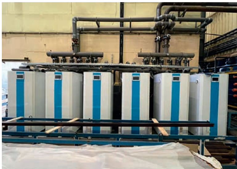
■ Промышленные тепловые насосы по 100 кВт для гальванического производства
