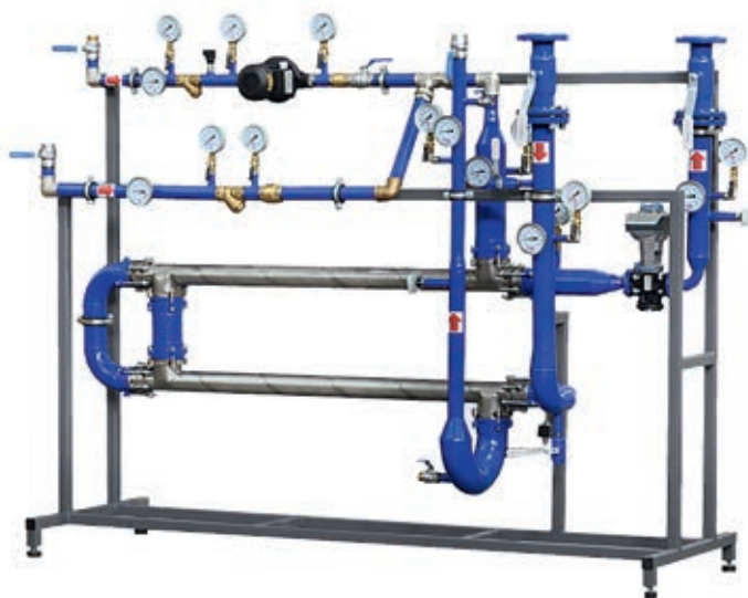
■ Рис. 3. Узел ГВС одноступенчатый с кожухотрубным теплообменником
