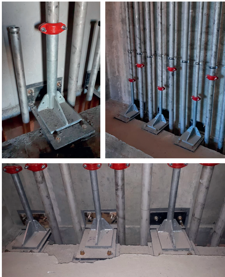
Рис. 4. Монтаж универсальных узлов неподвижного крепления
