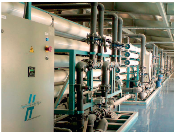
Рис. 2. Установка низконапорного обратного осмоса «Энерго-100»
