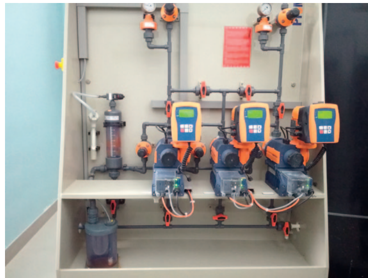
Дозирующая станция укомплектована датчиками, регуляторами, дозирующими насосами и емкостями и полностью готова к дозированию жидких реагентов
