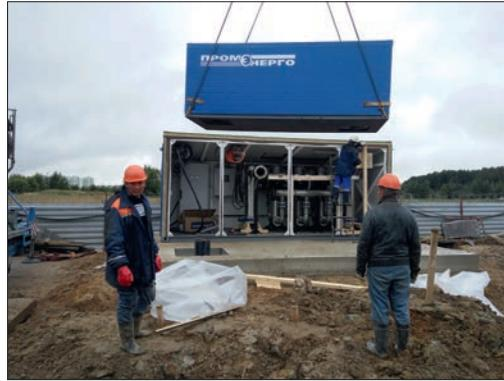
Рис. 5. Двухсекционная повысительная водопроводная насосная станция, реализованная в соответствии с проектом при строительстве систем инженерного обеспечения объектов жилищной застройки квартала в районе Янино-1 (Ленинградская обл., Всеволожский р-н)
