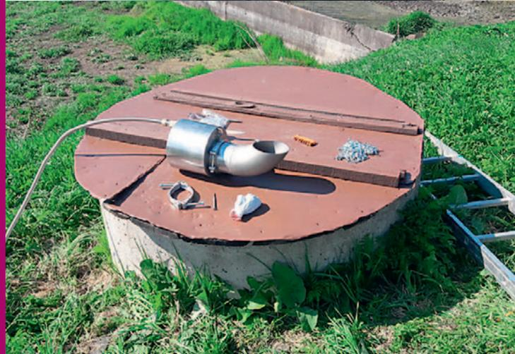
В деревне Гладкое, на одном из объектов ООО «ЛОКС» – поставщика коммунальных услуг в Ленинградской области, установлен первый расходомер сточных вод ВЗЛЕТ СК. Это совершенно новый прибор, специально разработанный для учета в затопляемых колодцах (защита IP68)
