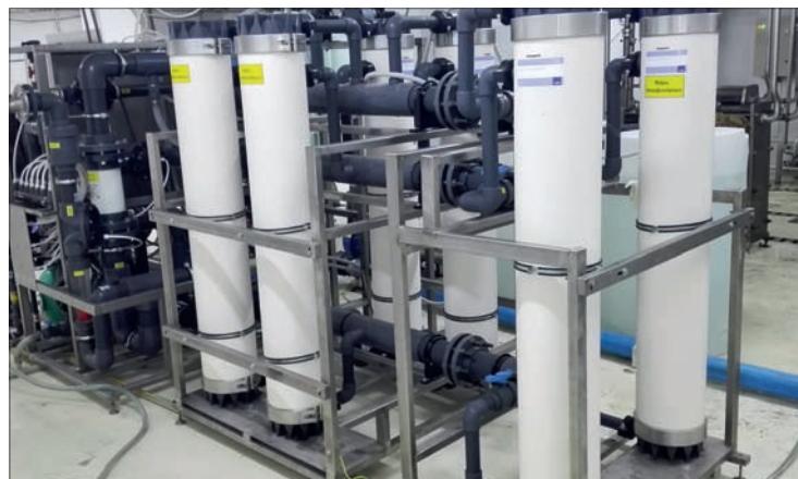
Рис. 3. Установка ультрафильтрации компании ООО «НПЦ ПромВодОчистка»
