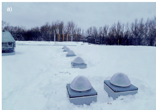
Рис. 2. Работа световодной системы в пасмурную зимнюю погоду (Ярославль, 15 января, 16:00): а) вид снаружи; б) вид изнутри помещения
