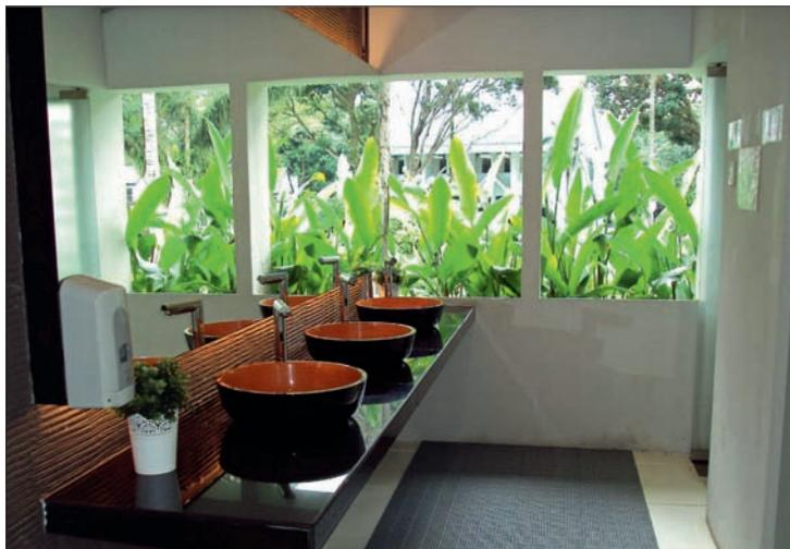
Использование плоскдонных умывальников не рекомендуется. Конструкция таких умывальных раковин не позволяет эффективно смывать грязь и мусор в сливных трубах.
