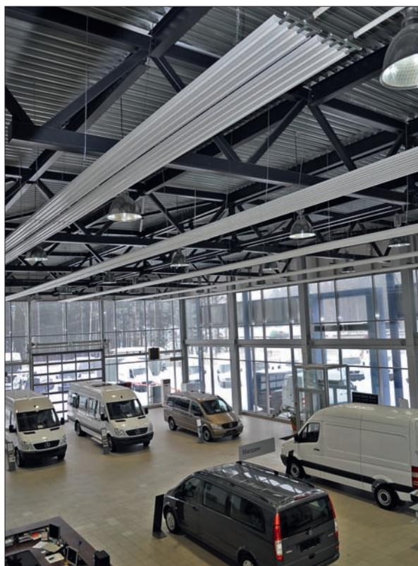
облегчавший транспортировку и монтаж панелей, полностью оцинкованная поверхность, позволившая применять ее в помещениях с повышенной влажностью, а также модульная конструкция, давшая возможность оперативно реагировать на изменения проекта.
