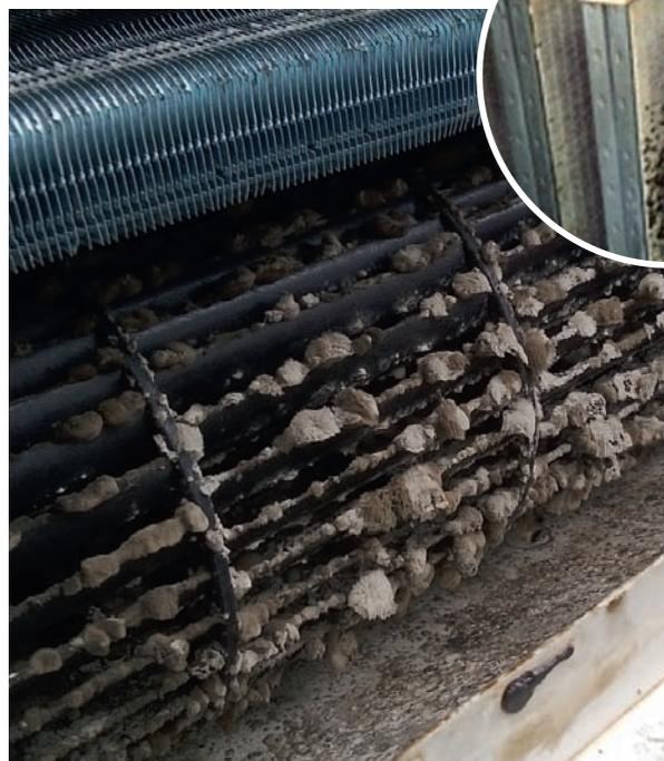
■ Рис. 1. Загрязненный фильтр, на поверхности которого в процессе эксплуатации осела и размножилась плесень
