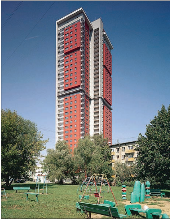
■ 34-этажный жилой дом на ул. Сельскохозяйственной (Москва). Крышная котельная мощностью 3,4 МВт
