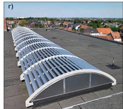
■ Рис. 1. Различные солнцезащитные устройства: а – горизонтальные; б – вертикальные; в – солнцезащитные устройства фонарей верхнего света; г – наружные солнцезащитные регулируемые экраны
