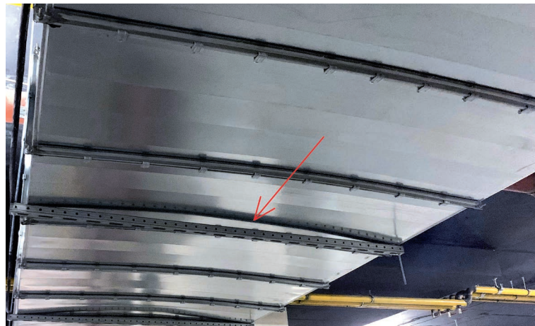
■ Рис. 4. Прогиб уменьшил проходное сечение воздуховода более чем на 10 %
