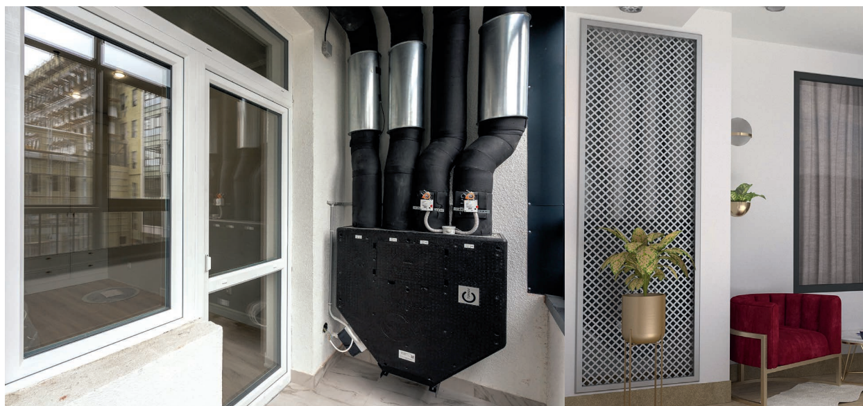
■ Поквартирные ПВУ размещены на балконах и лоджиях
