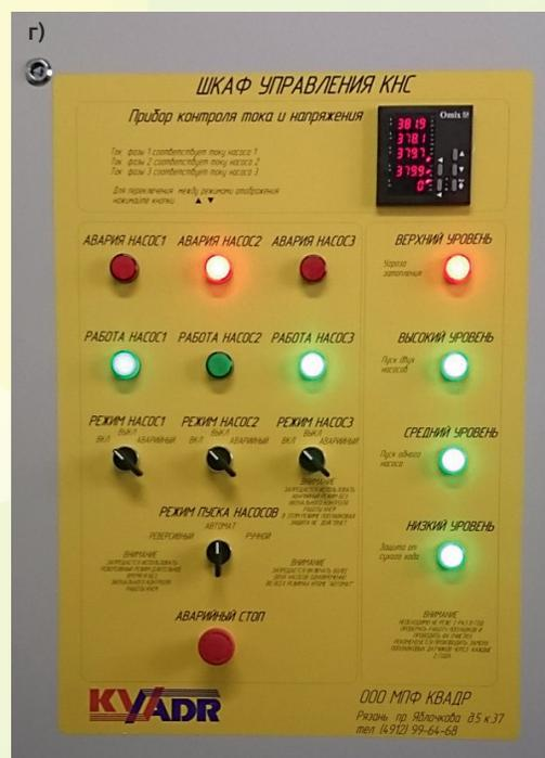
Рис. 1. Блочно-модульная насосная станция (а), корпус КНС в сборе (б), насосная станция водозаборного сооружения (в), лицевая панель шкафа управления КНС (г)
