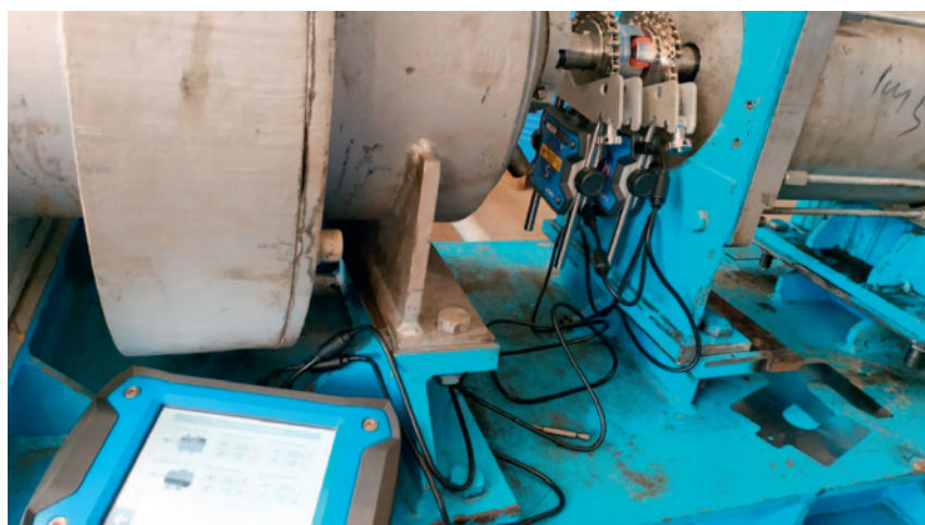
Рис. 4. Центровка валов турбины и генератора
