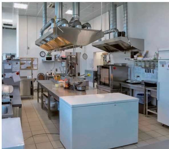
■ Рис. 1. Горячий цех с пристенными и островным вентиляционными зонтами
