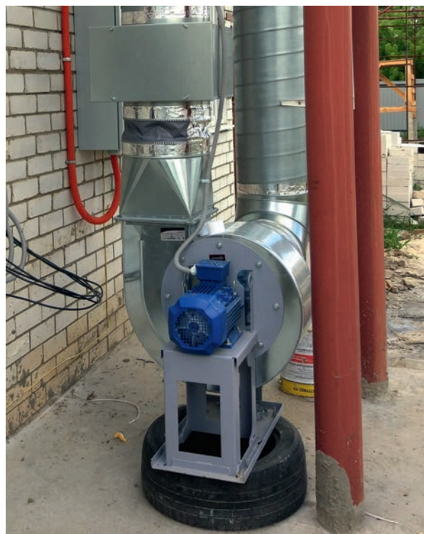
■ Рис. 3. Центробежный вентилятор, установленный на улице
