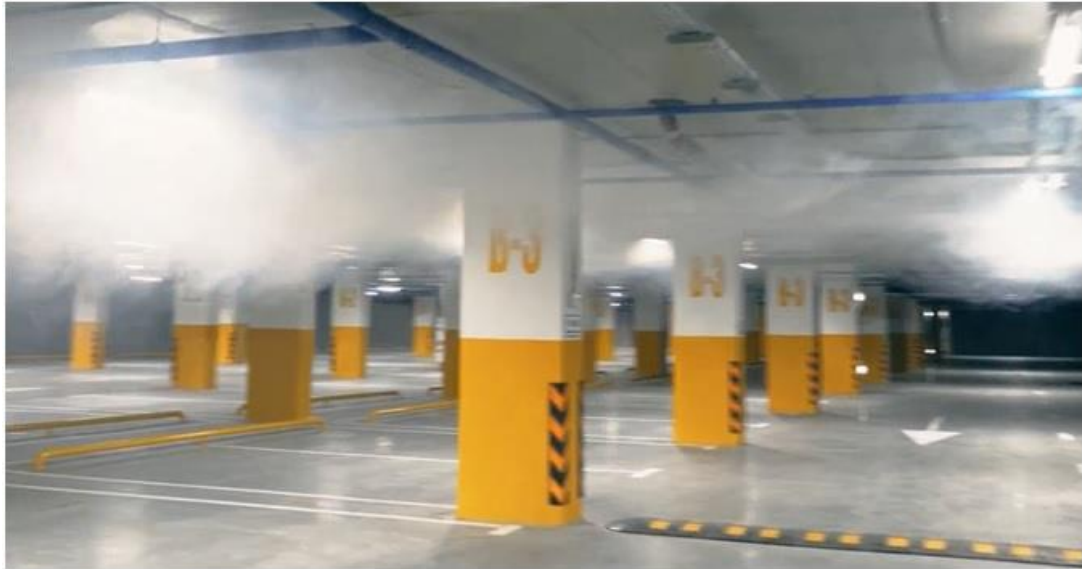
Рис. 8 Фрагмент испытаний горячим дымом при пусконаладочных испытаниях противодымной продольной вентиляции подземной автостоянки в Казани.
