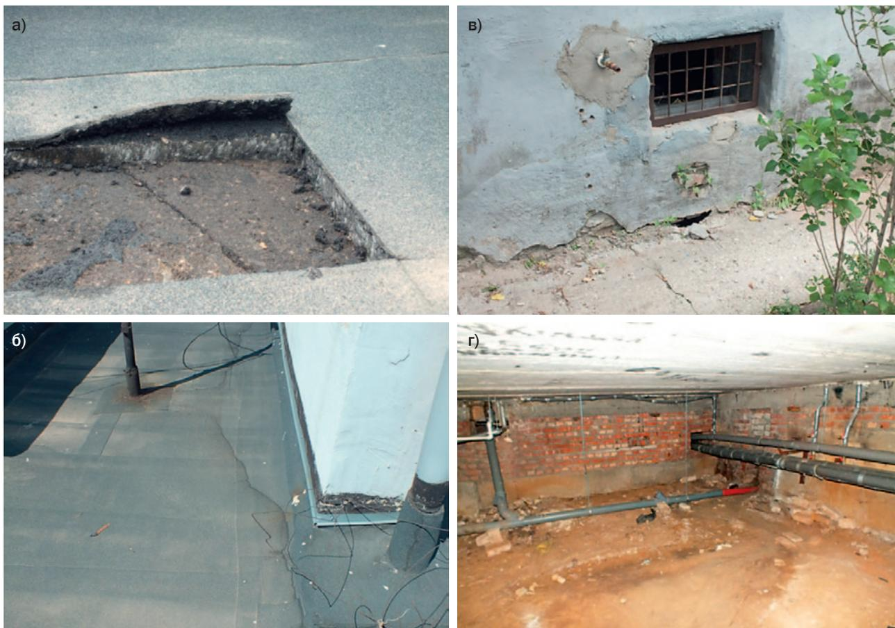
**Рис. 2.** Строительно-эксплуатационные дефекты ограждающих конструкций: а – деструкция элементов покрытия; б – необеспечение требуемых уклонов кровли; в – разрушение в зоне примыкания отмостки к цоколю; г – неутепленные конструкции подвала
