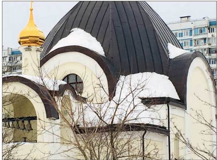
Рис. 2. Места образования снеговых карманов: храм Священномученика Ермогена, Патриарха Московского и всея Руси, в Крылатском
