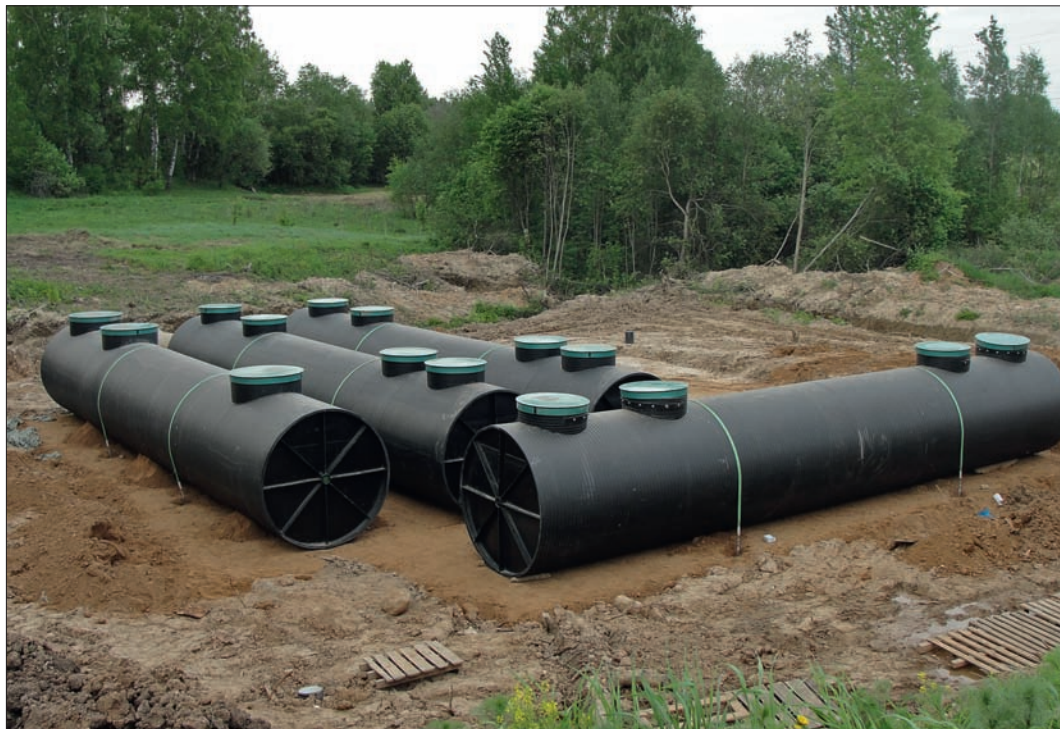
Автономные очистные сооружения
