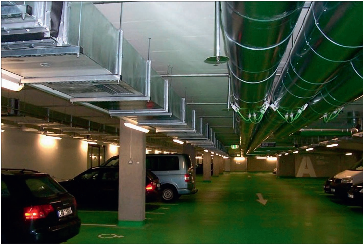
■ Рис. 1. Современная подземная автостоянка, оснащенная канальной противодымной вентиляцией
