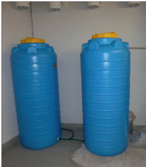
■ Система сбора ливневых вод
