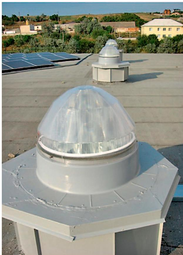
**Рис. 2.** Гибридная система солнечного освещения на основе световодов на вокзале Анапы
