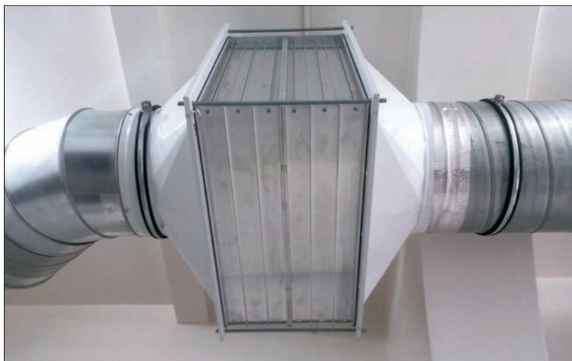
■ Рис. 4. Установка фильтра через фланцевое соединение
