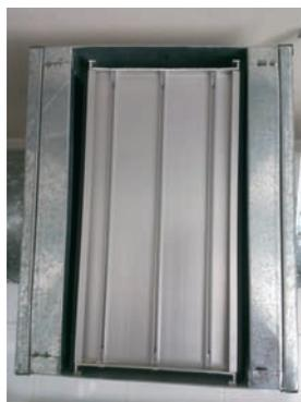
■ Рис. 3. Утечка воздуха через фильтр, установленный в неправильно спроектированный фильтр-бокс. Уплотнители не поджаты
