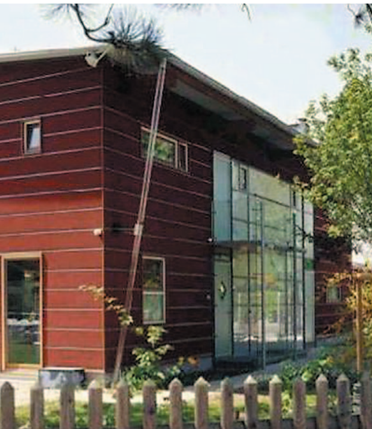
Рис. 2. Новое строительство в Мюнхене (Германия) с использованием планок из древесины в качестве защиты вакуумных изоляционных панелей (фото Lichtblau Architects)
