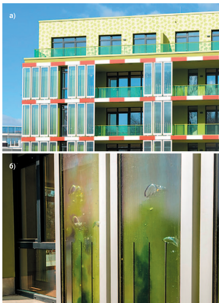
Рис. 1. Экспериментальное здание с панелями, в которых растут водоросли, представленное на строительной выставке в Гамбурге: а) фасад здания; б) панели с водорослями
