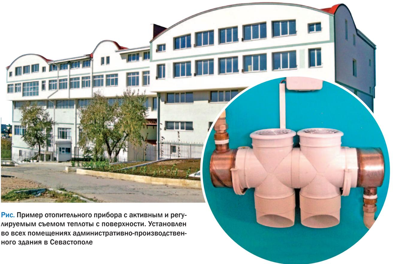
**Рис.** Пример отопительного прибора с активным и регулируемым съемом теплоты с поверхности. Установлен во всех помещениях административно-производственного здания в Севастополе
