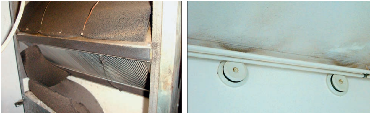
■ Рис. 2. Слева: несвоевременная замена фильтров может привести к их разрушению, что видно на примере нижнего фильтра. Справа: неверный подбор анемостатов (расположение и несоблюдение скорости воздуха на выходе из устройства) может привести к появлению следов грязи и пыли
