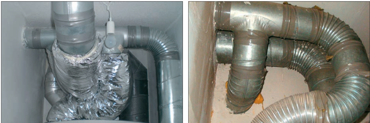
■ Рис. 3. Слева: гибкие шумоглушители не нужно использовать как отводы. Справа: иногда глушители в системе и вовсе отсутствуют
