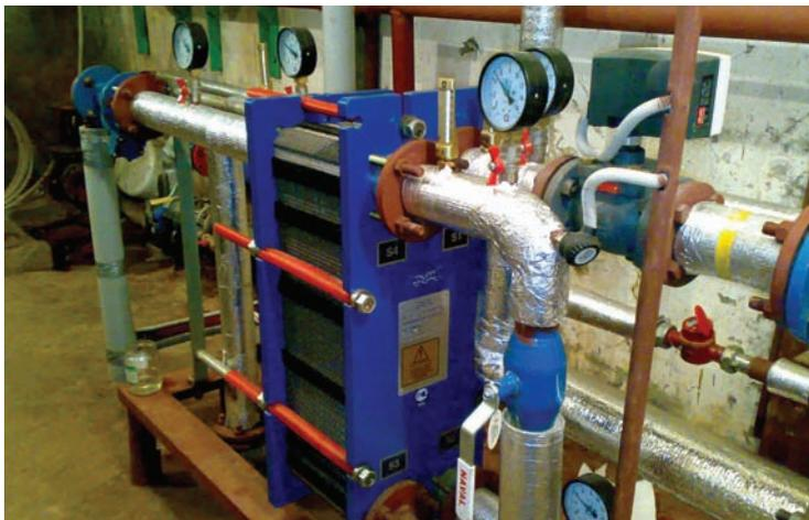
Рис. 2. Обвязка теплообменника
