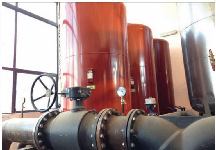
Рис. 1. Расширительные баки системы ГВС и отопления
