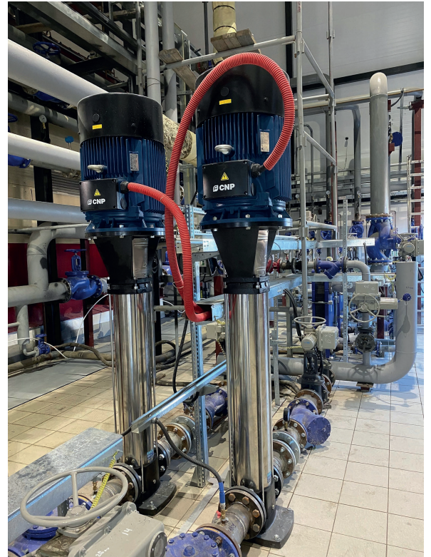
Рис. 6. Насосы CNP CDM на промывно-пропарочной станции
