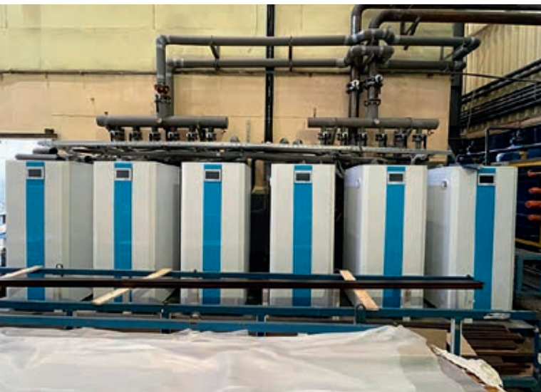
■ Промышленные тепловые насосы по 100 кВт для гальванического производства
