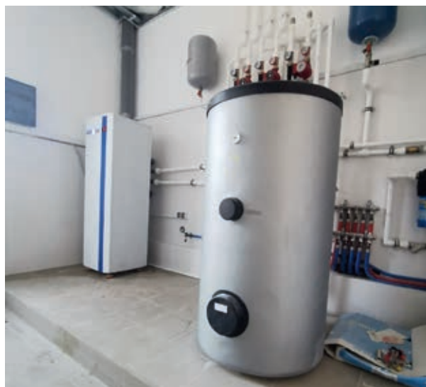
▪ Стандартный геотермальный тепловой насос
