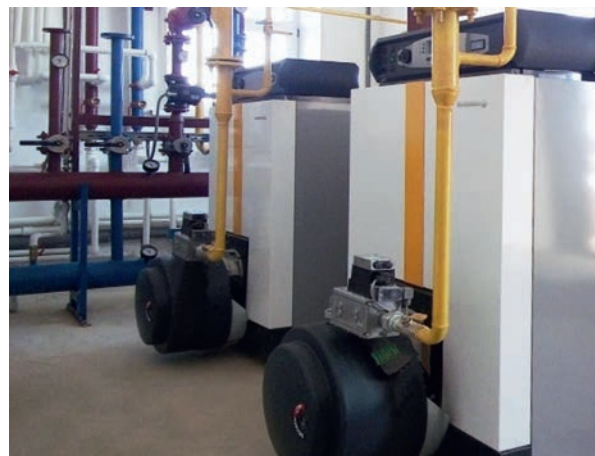
■ Установленные в основной котельной два напольных котла GT 338
