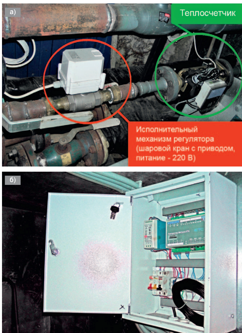
Рис. 2. Исполнительный механизм регулятора теплотребления (а) и смонтированный в шкафу контроллер Регулятора (б)
