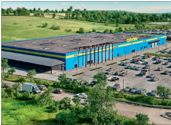
■ Рис. 1. Торгово-складской комплекс «Касторама»
